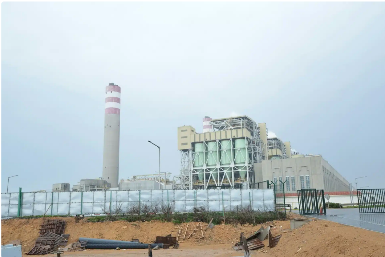
Le complexe industriel de Jorf Lasfar, où le groupe OCP exploite ses stations modulaires de dessalement. Photo Abdel El (@alallout), 27 février 2022, exploitée par MARAMM sous licence gratuite.
